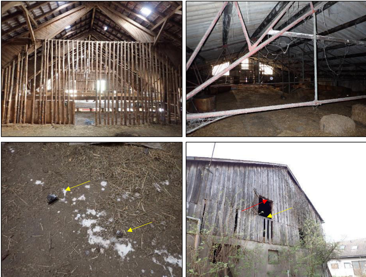
Abbildung 6: Luftige und helle Dachstühle der Gebäude B (nördlicher Teil, links oben) und C (rechts oben) mit Nutzungsnachweisen (Gebäude B) von Schleiereule (links unten, gelber Pfeil: Gewölle) und Fledermäusen (rechts unten, gelber Pfeil: Fundstelle Kot, roter Pfeil: ehemals genutztes Einzelquartier).
