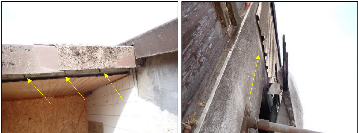
Abbildung 7: Potenzielle Spaltenquartiere für Fledermäuse an Gebäude C (gelbe Pfeile).
