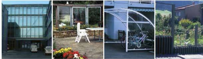
Passerelle Windschutz Veloständer Lärmschutzwand
