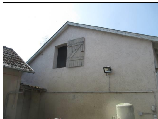
⑥ Klappe an der Ostseite Nr. 24, Einflugöffnung für Fledermäuse
