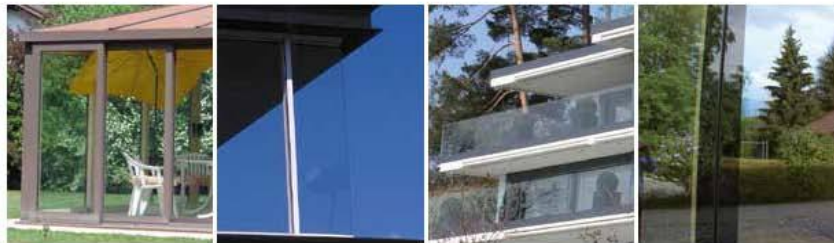
Wintergarten Eckkonstruktion Balkongeländer Spiegelnde Fassade
